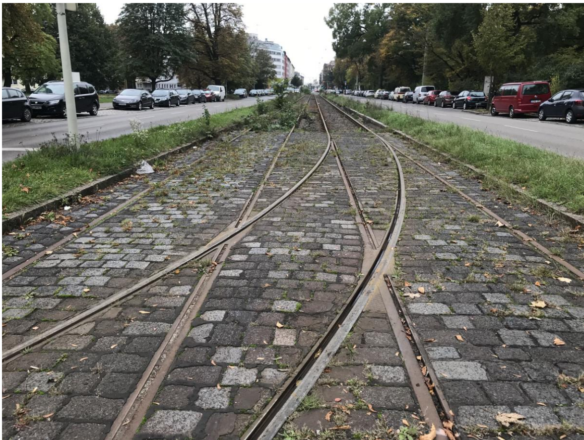
Abbildung 18: Gleise entlang Bayreuther Straße im Bereich Stadtpark
