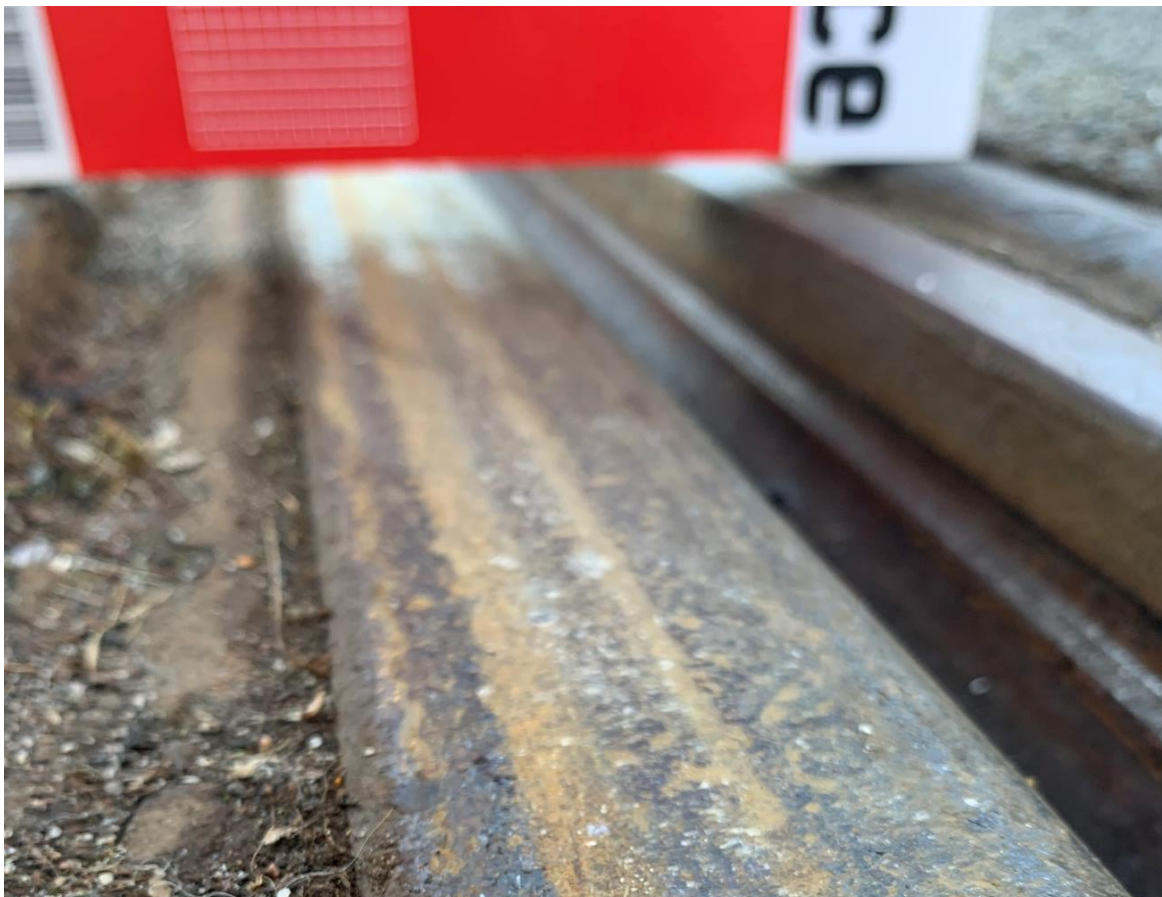
Abbildung 16: Verschleiß am Gleise entlang Berliner Platz
